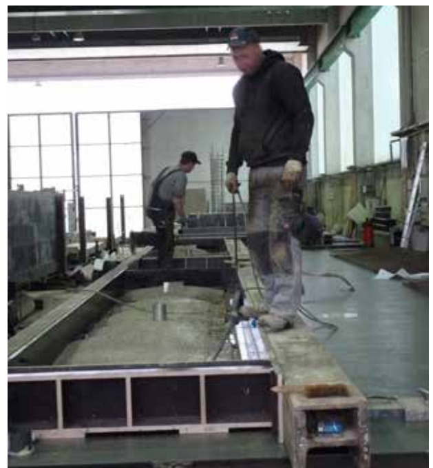
Bild 12: Verdichten des Betons in der Schalung im Fertigteilwerk
