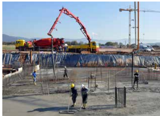
Bild 13: Einbau von Transportbeton mit Betonpumpe und Verdichtung durch Innenrüttler Foto: BetonBild
