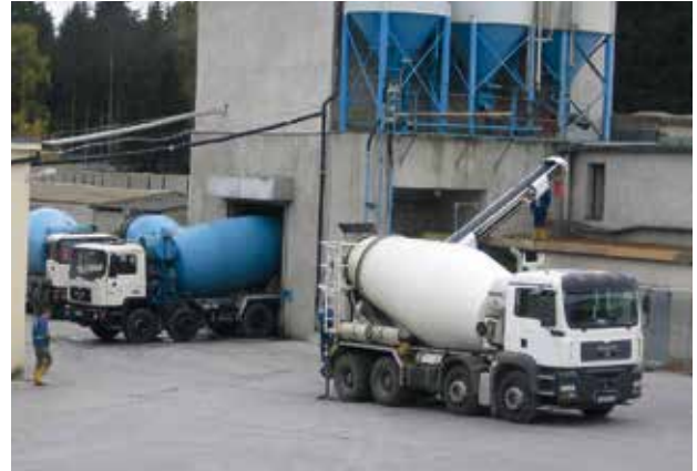
Bild 10: Laden des Frischbetons in den Fahrmischer
