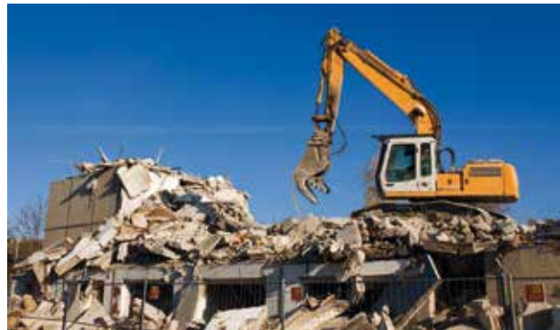
Bild 15: Abbrucharbeiten mit Bagger Foto: fotolia/A. Erdbeer
