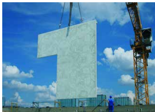
Bild 14: Montage eines Betonfertigteils Foto: BetonBild
