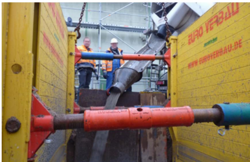
Ein typisches Einsatzgebiet: die Verfüllung von Gräben im Kanal- und Rohrleitungsbau aus dem Transportbetonfahrmischer | Foto: Holcim (Deutschland) GmbH
