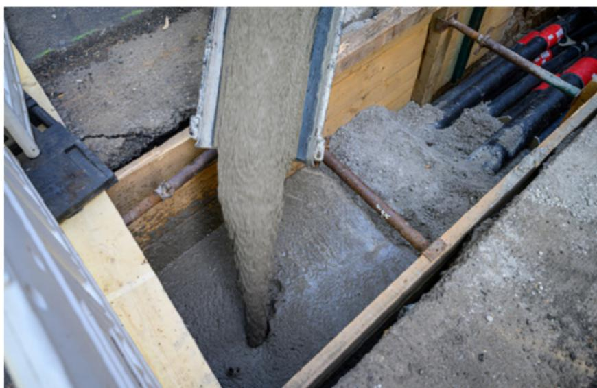
Einbau des Flüssigboden direkt aus dem Fahrnischer
