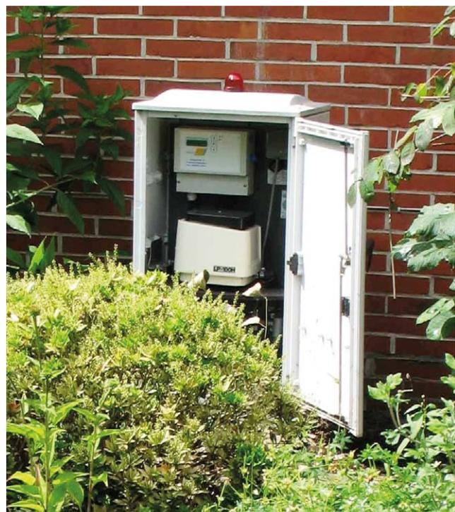
Bild 4: Schaltschrank mit Steuerungstechnik im Vorgarten
