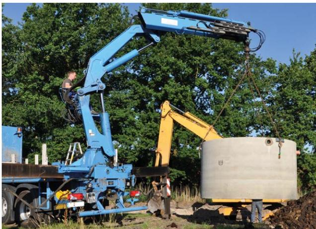
Bild 11: Einbau mit einem Versetzkran
