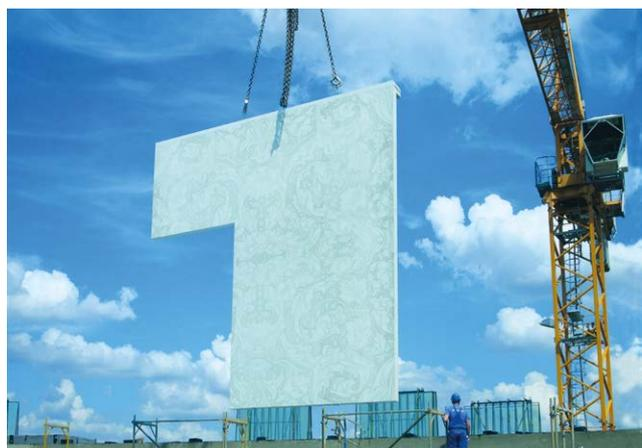
Abb. 13: Montage eines Betonfertigteils
