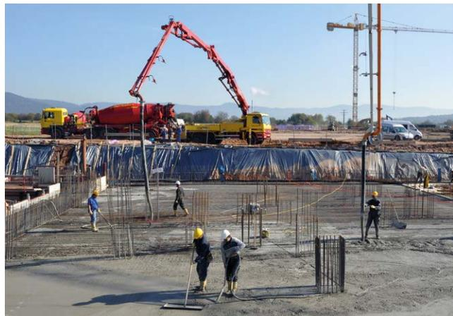
Abb. 12: Einbau von Transportbeton mit Betonpumpe und Verdichtung durch Innenrüttler
