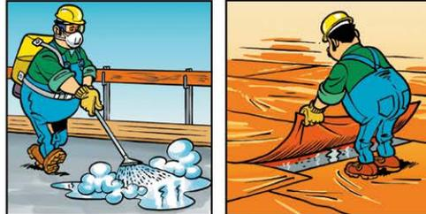
VERMEIDUNG DURCH ANWENDUNG EINES NACHBEHANDLUNGSMITTELS, AUFRECHTERHALTEN EINES WASSERFILMS ODER ABDECKEN DURCH MATTEN UND FOLIEN.
