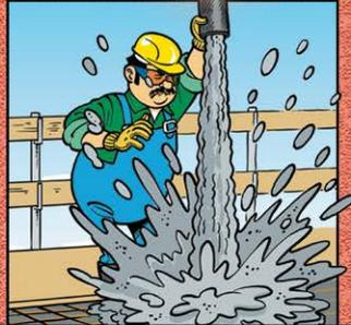
ENTMISCHUNGEN VERMEIDEN. DEN BETON NICHT MIT EINER ZU GROßEN FALLHÖHE EINBAUEN.
