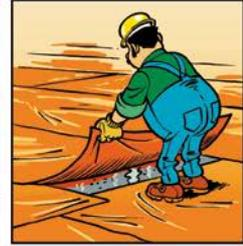
VERMEIDUNG DURCH ANWENDUNG EINES NACHBEHANDLUNGSMITTELS, AUFRECHTERHALTEN EINES WASSERFILMS ODER ABDECKEN DURCH MATTEN UND FOLIEN.
