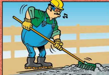
FALLS ES NOTWENDIG IST, DEN BETON ZU VERTEILEN, SIND SCHAUFEL ODER HARKEN ZU BENÜTZEN UND NICHT DIE VERDICHUNGSGERÄTE WIE Z. B. RÜTTELFLASCHEN.
