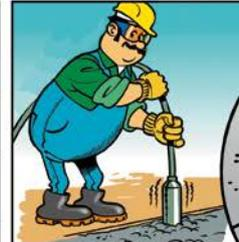
VERDICHTEN DES BETONS INNERHALB EINER STUNDE NACH DEM EINBAU.
