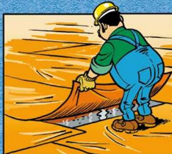
BEIM AUFBRINGEN VON MATTEN ODER FOLIEN IST AUF AUSREICHENDE ÜBERLAPPUNG ZU ACHTEN. DIE ABDECKUNG DER RÄNDER IST SICHERZUSTELLEN. AN DEN KANTEN UND STÖßEN SIND DIE ABDECKUNGEN GEGEN DURCHZUG ZU SICHERN.
