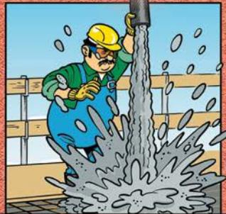
ENTMISCHUNGEN VERMEIDEN. DEN BETON NICHT MIT EINER ZU GROßEN FALLHÖHE EINBAUEN.
