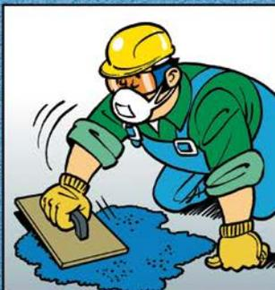
SOLLEN DIE OBERFLÄCHEN BESCHICHTET WERDEN, IST EIN SPEZIELL DARAUF ABGESTIMMTES NACHBEHANDLUNGSMITTEL ZU VERWENDEN.
