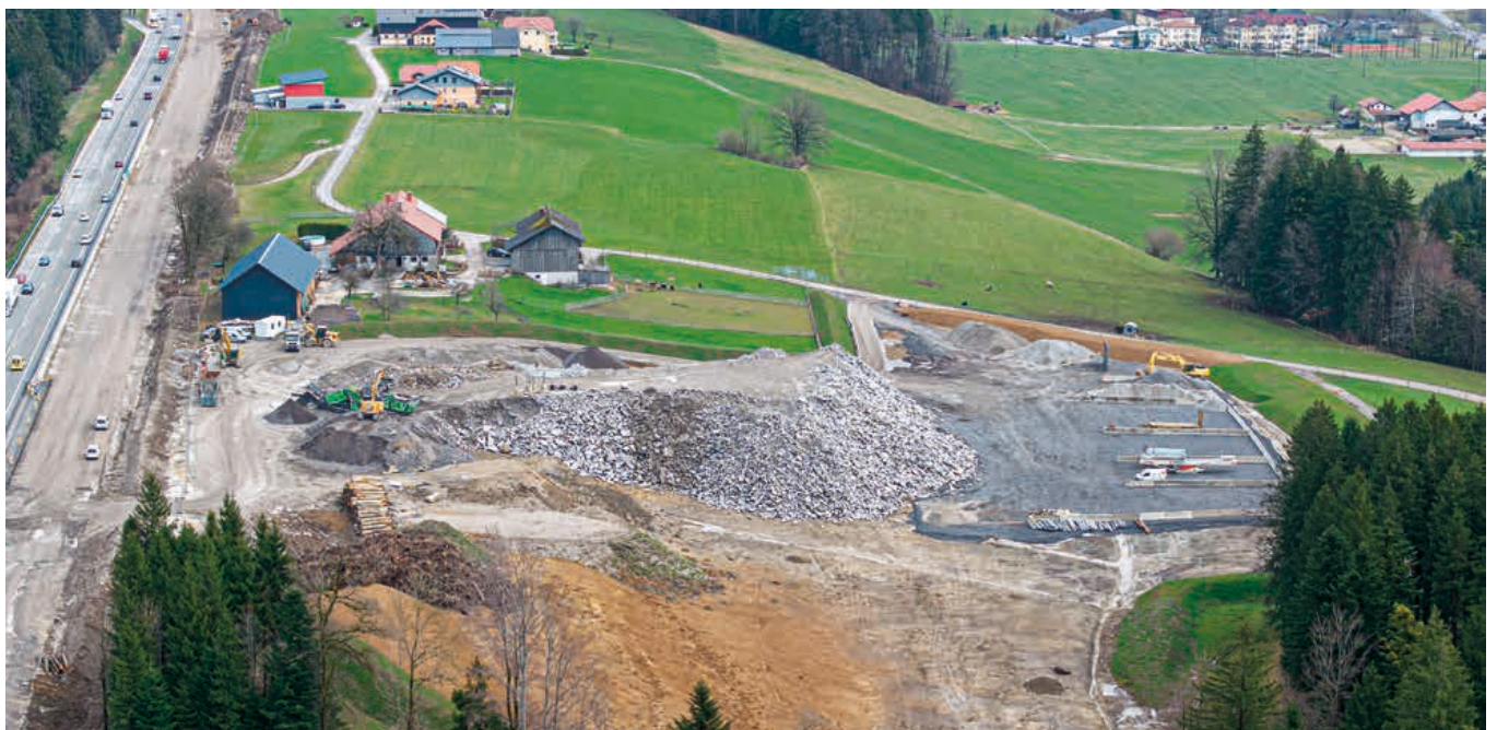
Der gesamte Betonabtrag wurde auf den zentralen Aufbereitungsplatz direkt neben der Baustelle gebracht und vor Ort aufbereitet.
