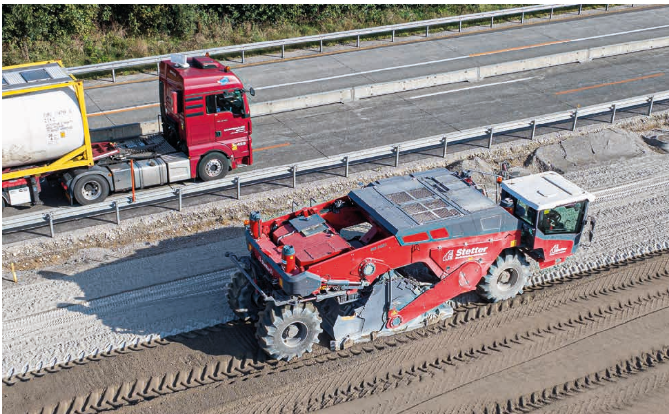
Zementstabilisierung: Der aufbereitete Beton wurde im Unterbeton bzw. in der zementstabilisierten Tragschicht verwendet.
