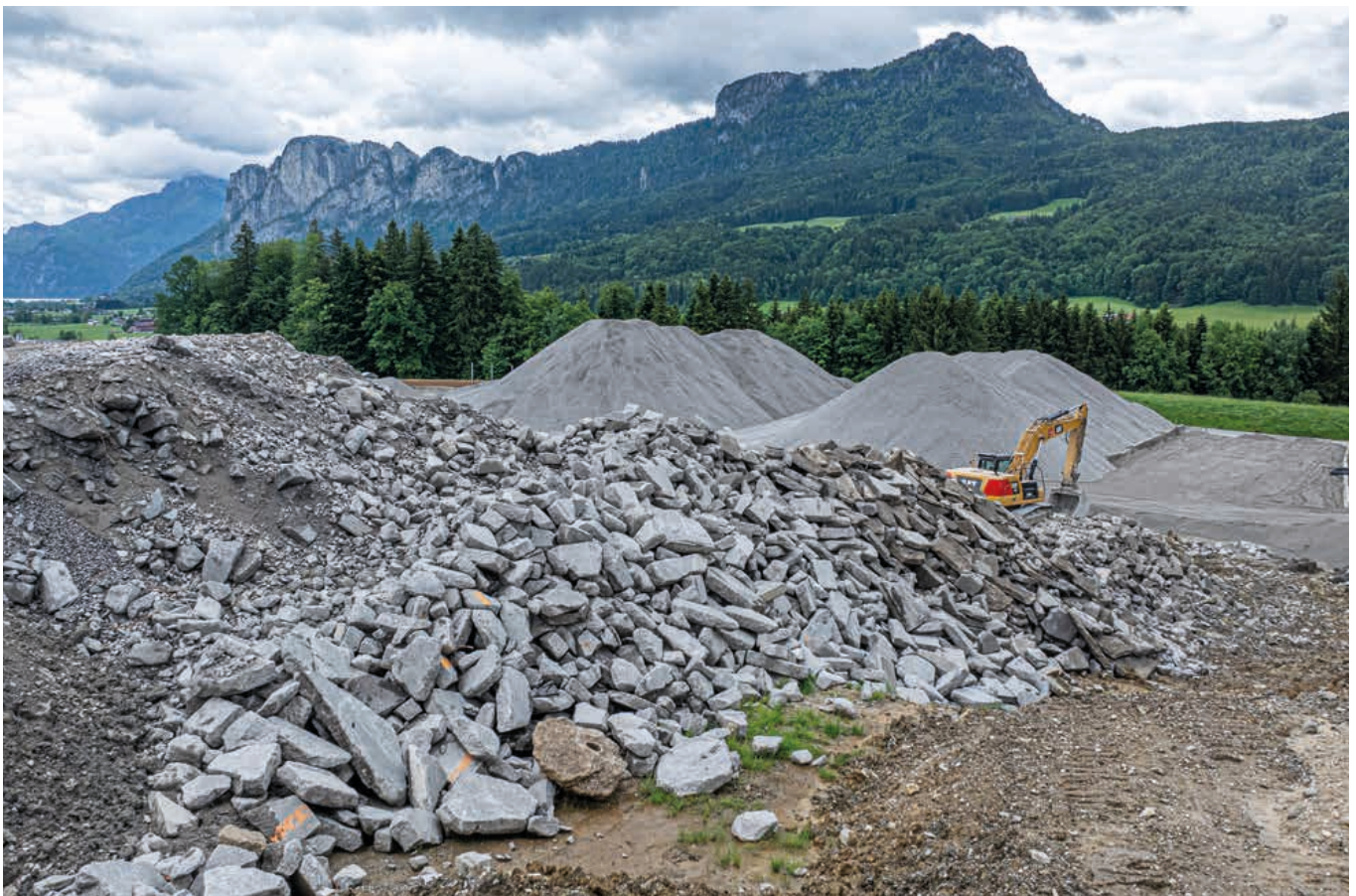
Der Betonbruch wird so aufbereitet, dass die Recycling-Gesteinskörnung nach der Aufbereitung der Körnung eines normalen Kieswerks entspricht.
