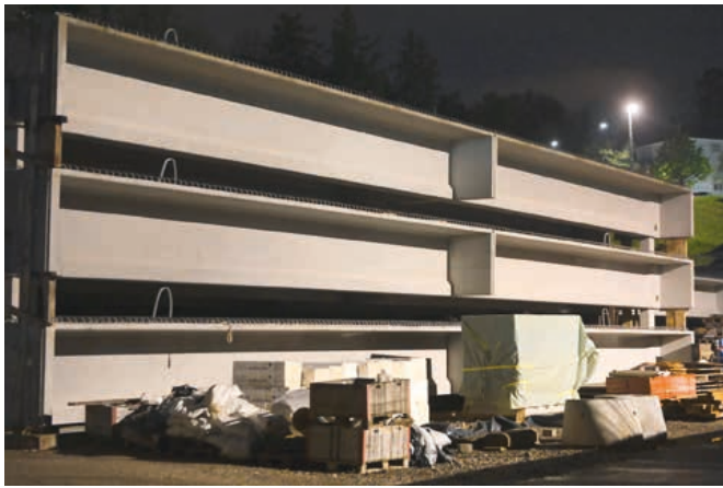
Lager auf der Baustelle Bild: leistungsfotografie.ch
