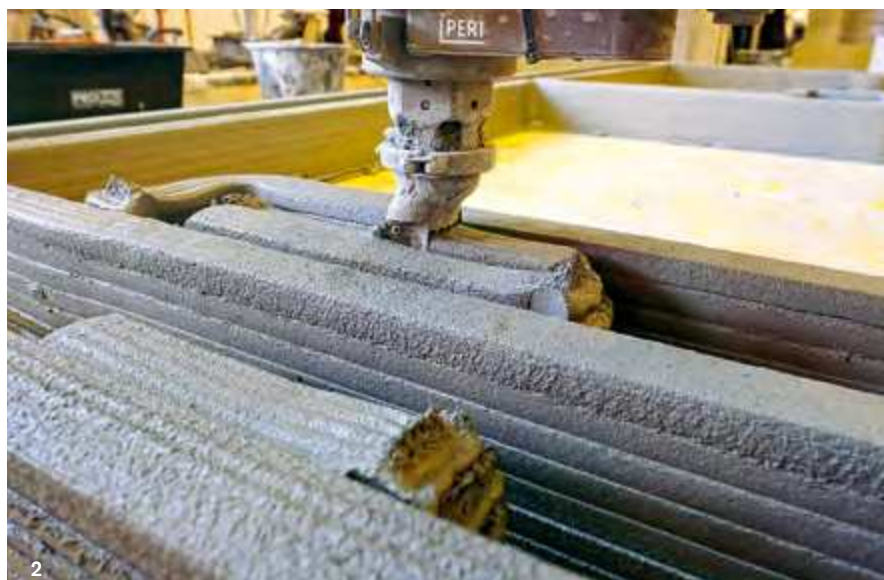
1 + 2 Die Wände des Einfamilienhauses in Beckum wurden dreischalig gedruckt: Der Druckkopf fährt dabei ständig hin und her und schichtet die gepressten Betonschlangen präzise aufeinander; der entstandene Luftraum wird mit Dämmmaterial aufgefüllt. Aussparungen und Schlitze für später ausgeführte Leitungen und Anschlüsse werden während des Druckvorgangs mitberücksichtigt.
